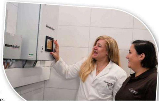
Oben: Ulrike Ganzenmüller (l.) erläutert Magdalena Kreitmaier die Steuerung der Wärmerückgewinnungsanlage. Unten: Jederzeitige Datentransparenz zählt zu den Vorzügen der Investition.
